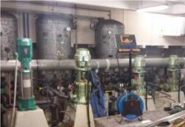
Veraltete Technik und Schäden an Rohrleitungen
