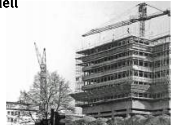
Rathaus Kaiserslautern im Bau 1964
