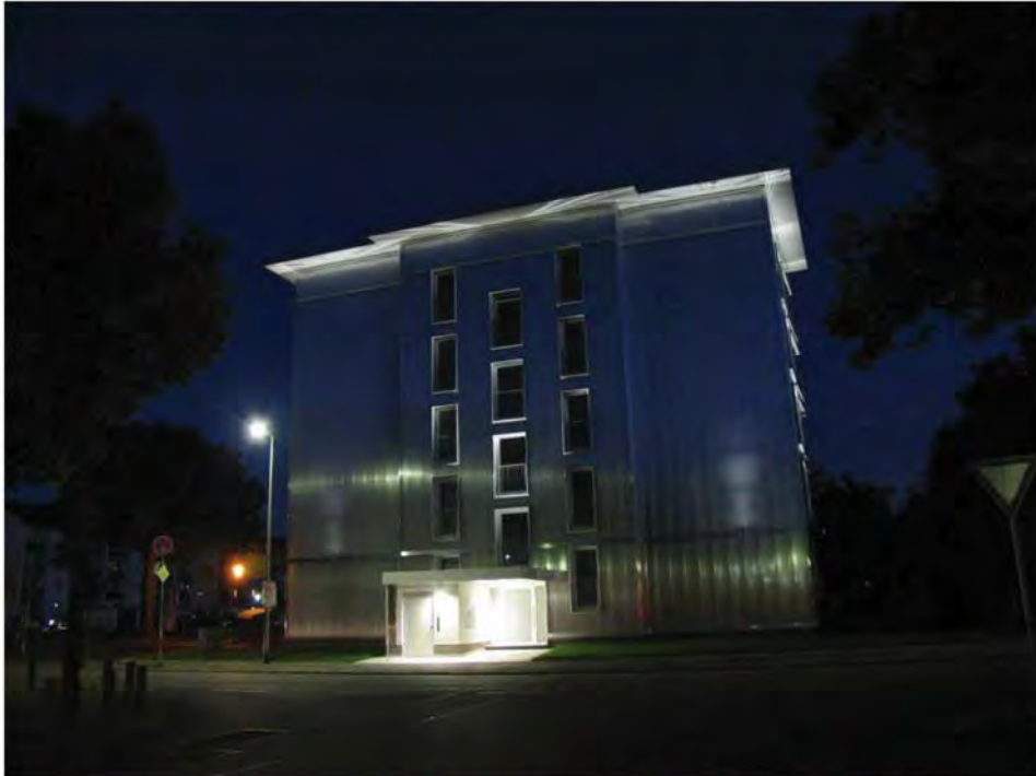
Straßen- bzw. Nordansicht: Lilienthalstraße 232, Mannheim-Schönau
